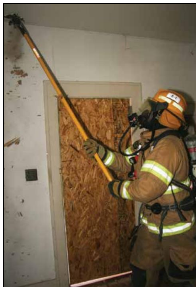
شکل ۱۰۰ آتش‌نشان با استفاده از شیروانی کن، بخشی از سقف را باز می‌کند تا حریق‌های پنهان را پیدا کند.
