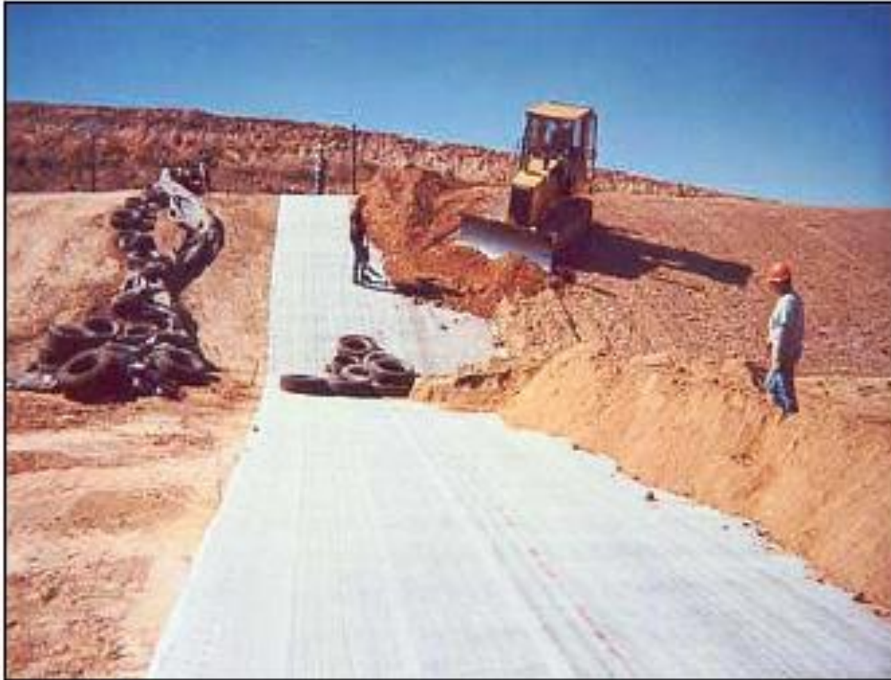
اجرای لایه‌ی پوششی بر روی GCL
